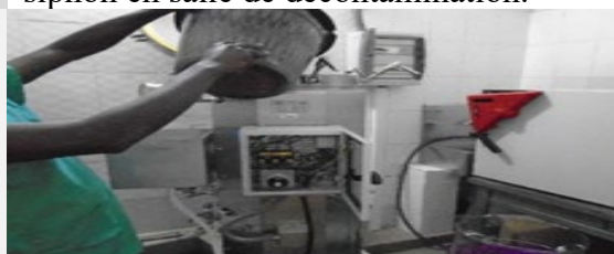
Photo 3. Coffret électrique exposé à l'eau.
